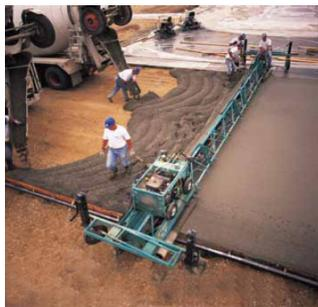
O sistema **laje-fundação**, resolveu definitivamente todas as questões associadas com a instabilidade dos solos naturais, bem como o problema das trincas por retração ou por recalque diferencial das fundações naturais.
