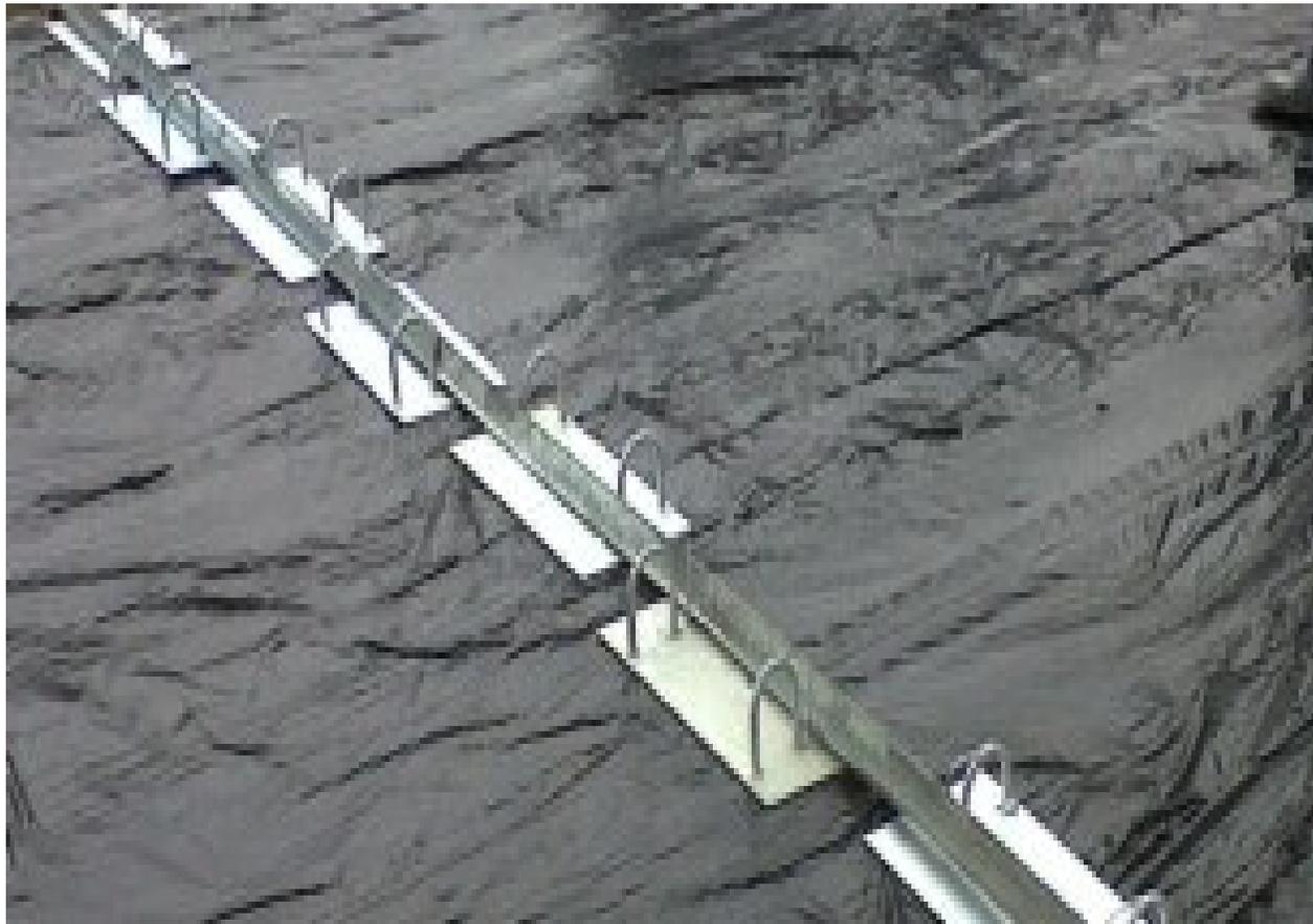
Ejemplo de placas de transferencia de carga encima de la película de polietileno
